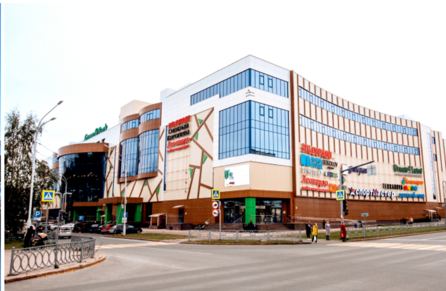
2. Центральный фасад. Справа
